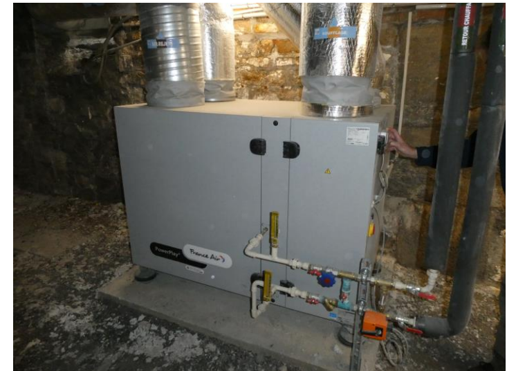
Centrale de Traitement d'Air (CTA)
