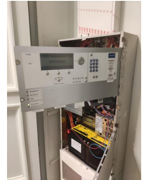
Centrale d'alarme SSI
