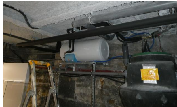
Chaudière à accumulation et bac à graisse au R-1
